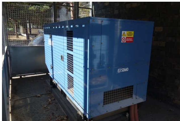
Instalovaný dieselagregát (13)
